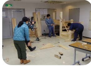
階段班の制作風景 次期パンフの写真撮影中
