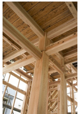
第20期生（2年生）による実習棟。大黒柱を貫く梁の構造が良く分かる。
