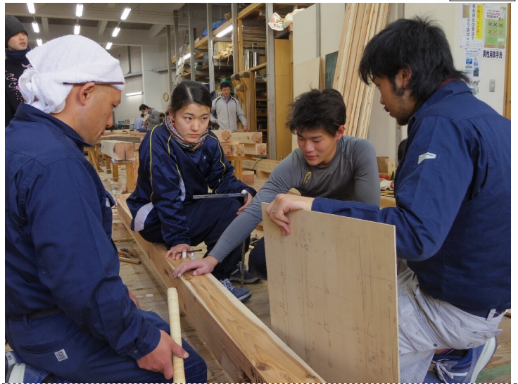
1月19日(金)・20日(土)実施「建方・上棟」の見学歓迎!
