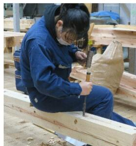
自分たちで墨付け、刻みを行った部材で木造軸組み2階建ての建築を建てる実習棟実習は、本校の教育プログラムの中でもっとも代表的な授業です。しかも、1階部分は木組みだけの伝統構法でつくります。現代の新築住宅現場はプレカット材の組み立て作業が主流なので、貴重な体験です。上棟・建方は1月22日・23日の予定。大工職はもちろん、設計や施工管理などに従事する研修生も学ぶ意義を日々実感しながら取り組んでいます。
