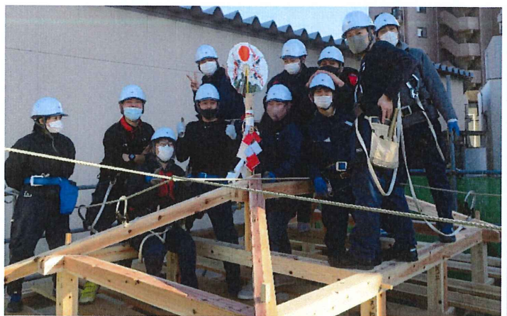
↑2021年1月 第25期生 実習棟の上棟後の記念撮影。
