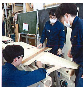
原寸図に基づき慎重に墨付けする研修生たち
