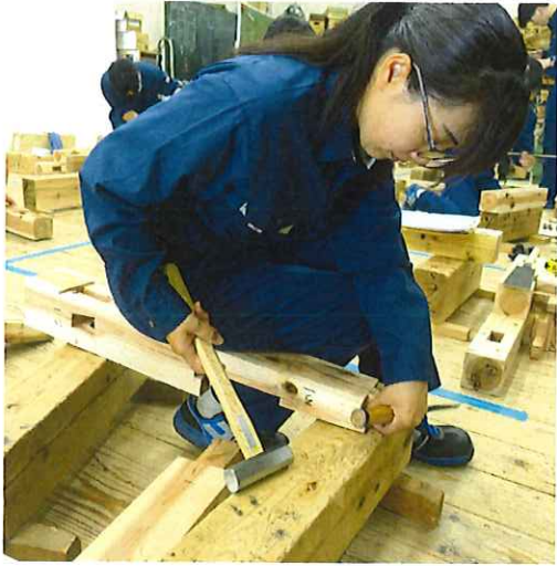
上写真：精度を高めるため金輪継手を調整中。 右写真：カレッジ・フレームの完成で互いの成長を確認する研修生たち(6月22日、江東実習場)
