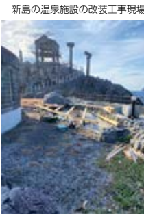
新島の温泉施設の改修工事現場
